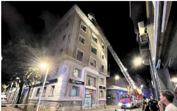
CARRER SANT RAFAEL. Incendi al terrat de l'edifici, diumenge a la matinada AJ. DE FIG.
